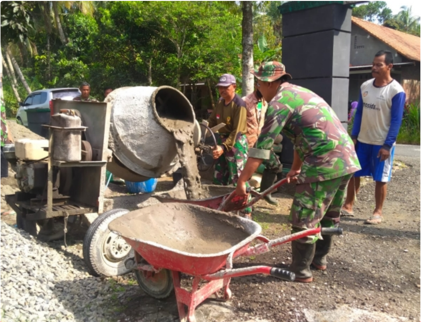
Anggota Posramil Bonorowo Bantu Warga Pengecoran Jalan
